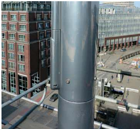
Mastrohr 2-teilig mit Drehlagerung, Fassadenmontage
