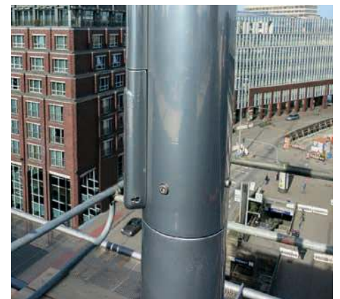
Mastrohr 2-teilig mit Drehlagerung, Fassadenmontage
